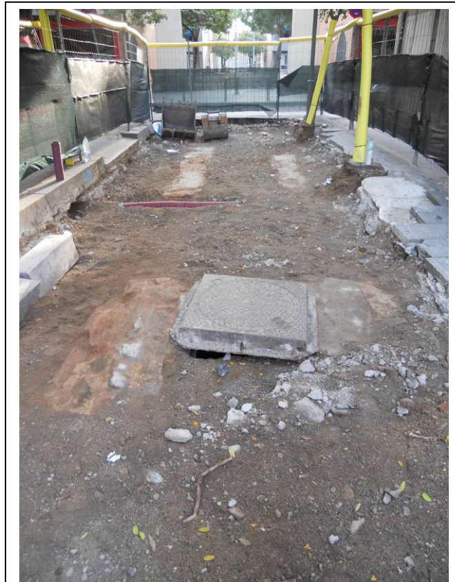
Parets del col·lector 1. Vist des del sud-oest.
